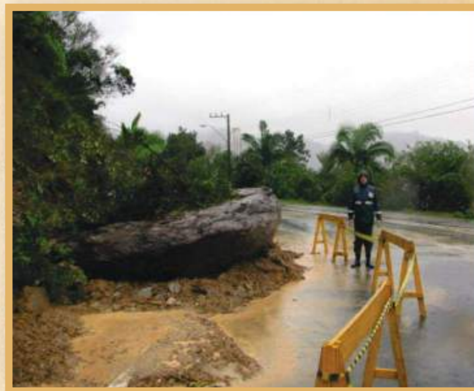
Figura 3. – Queda de bloco rochoso. Cabeçudas, Itajaí SC. Foto: Compdec
