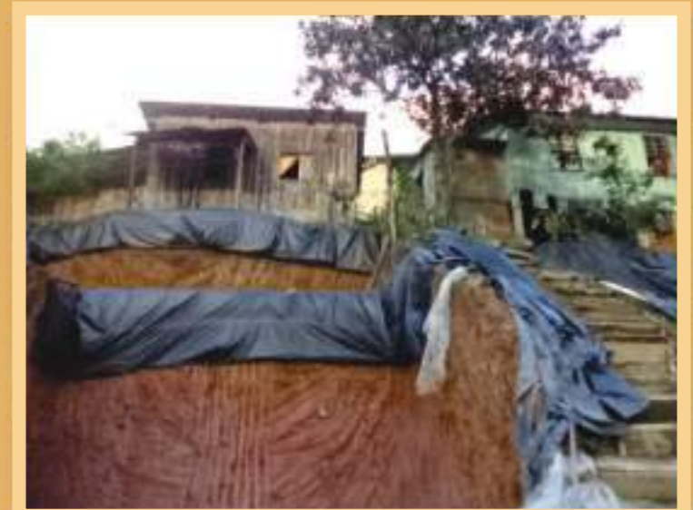
Talude de corte. Bairro Limoeiro
