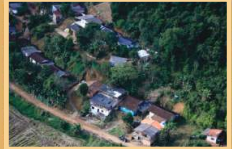
Padrão construtivo. Bairro Limoeiro
