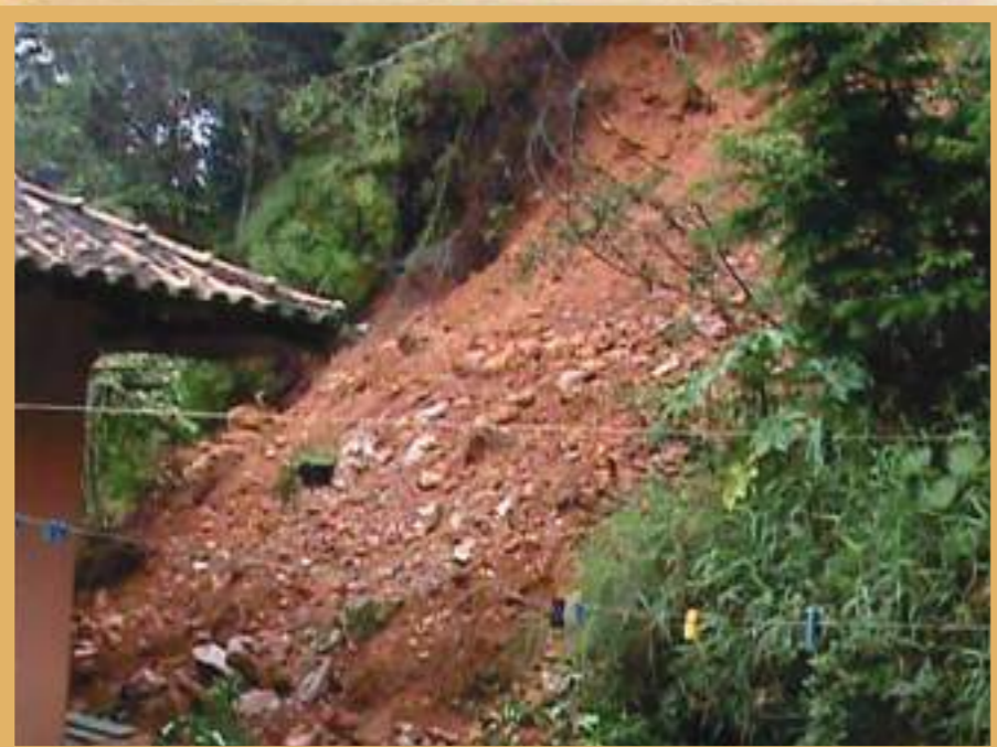
Figura 13 - Escorregamento de solo + blocos rochosos. Bairro Carvalho. Foto: Compdec
