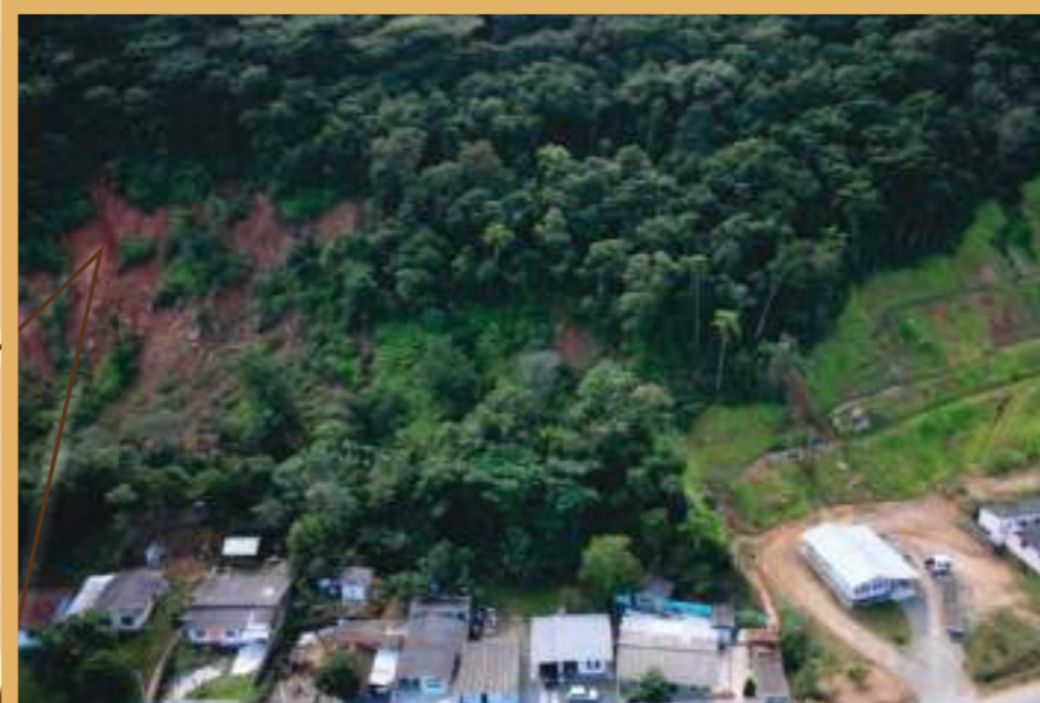
Figura 11 - Área susceptível a escorregamentos. Rua Fermino V. Cordeiro. Bairro Espinheiros Foto: SECOM. PMI
